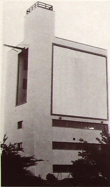
Der einseitig offene Absorberraum des neuen Antennenmeßplatzes der MBB ist in Richtung zur Gegenstelle mit einer für elektrische Wellen durchlässigen Plane abgeschlossen
